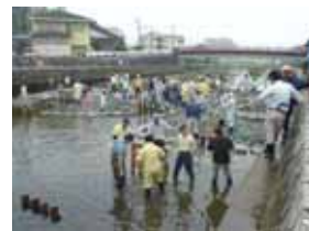
写真 - 7 浄化材設置状況
